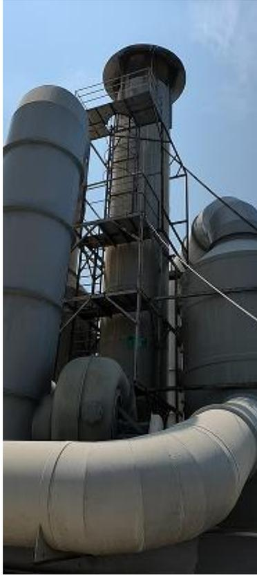
图 4.5-6 锌镍生产线废气治理设施
