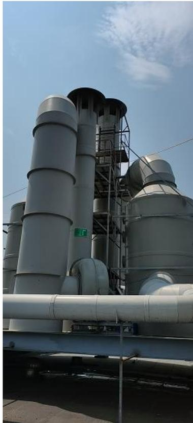
图 4.5-5 2#电泳线废气治理设施
