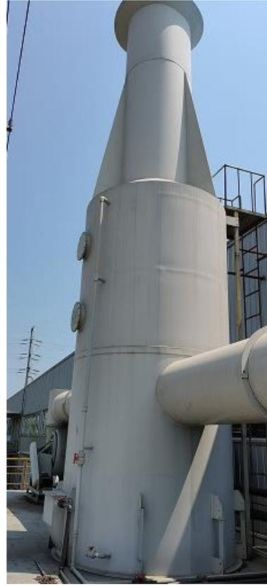
图 4.5-3 镍锡电镀自动线废气治理设施
