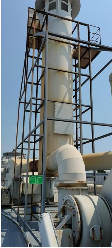
图 4.5-2 电镀铜镍锡生产线废气治理设施
