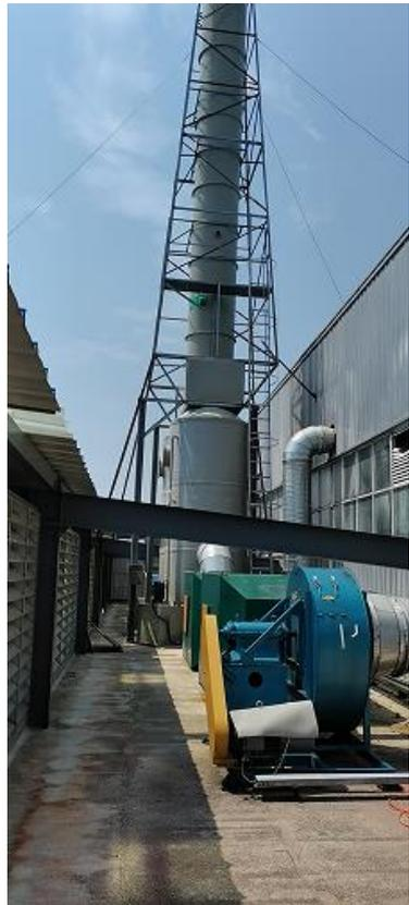
图 4.5-4 1#电泳生产线废气治理设施
