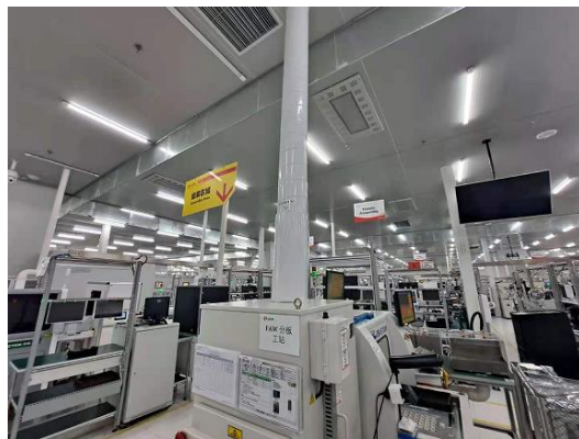
图 4.5-3 生产线废气收集系统
