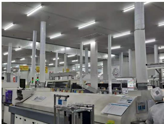
图 4.5-3 生产线废气收集系统
