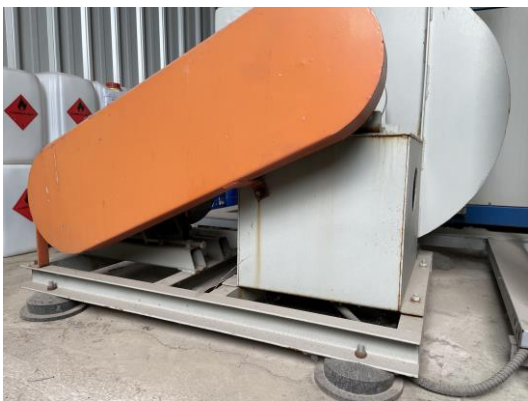
图 4.5-8 风机减振基础
