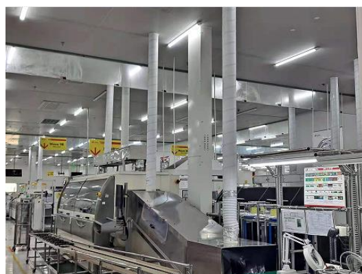
图 4.5-4 生产废气负压收集管道
