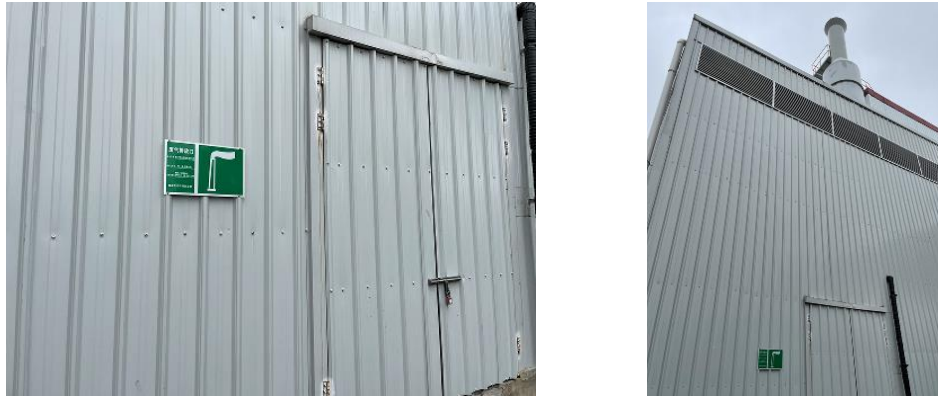
图 4.5.5-2 1#废气排放口及标识牌
