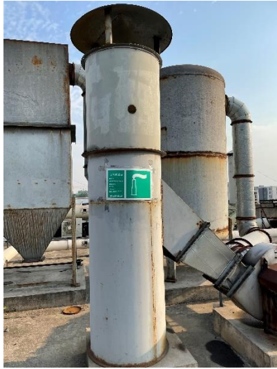
图 4.5-2 混料废气处理设施及 1#排气筒
