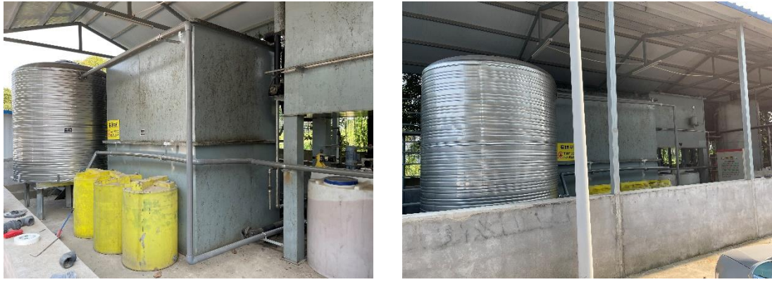
图 4.5-10 废水处理站新增 A/O 处理工艺
