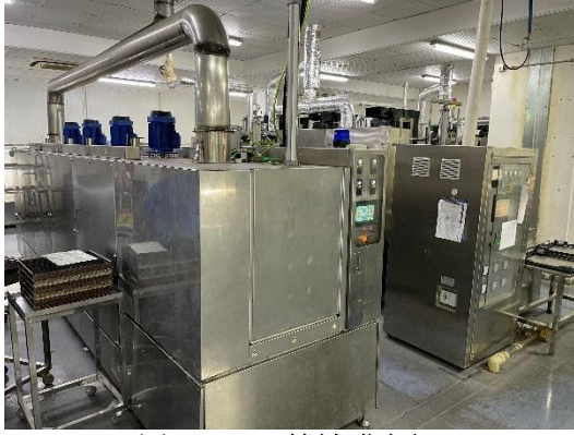
图 4.4-1 一楼被膜车间
