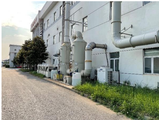
图 4.5-7 新增废气洗涤塔及 6#排气筒
