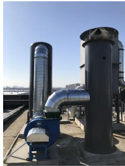
图 4.5-5 铸模废气处理设置及 4#排气筒
