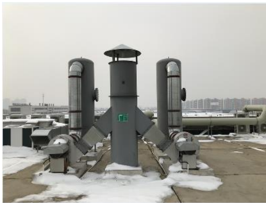
图 4.5-4 聚合废气处理设置及 3#排气筒
