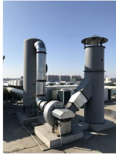
图 4.5-3 聚合废气处理设置及 2#排气筒
