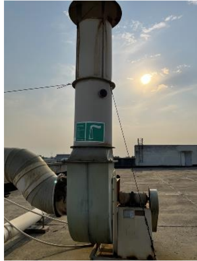
图 4.5-7 新增废气洗涤塔及 6#排气筒
