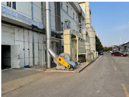
图 4.5-6 新增活性炭吸附及催化燃烧设置及 5#排气筒
